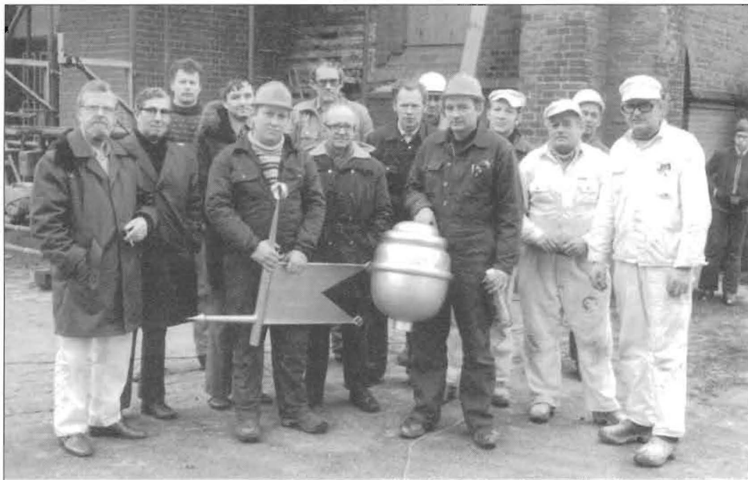
Ved istandsættelsen i 1974 var kuglen og vindfløjen atter engang nede.
